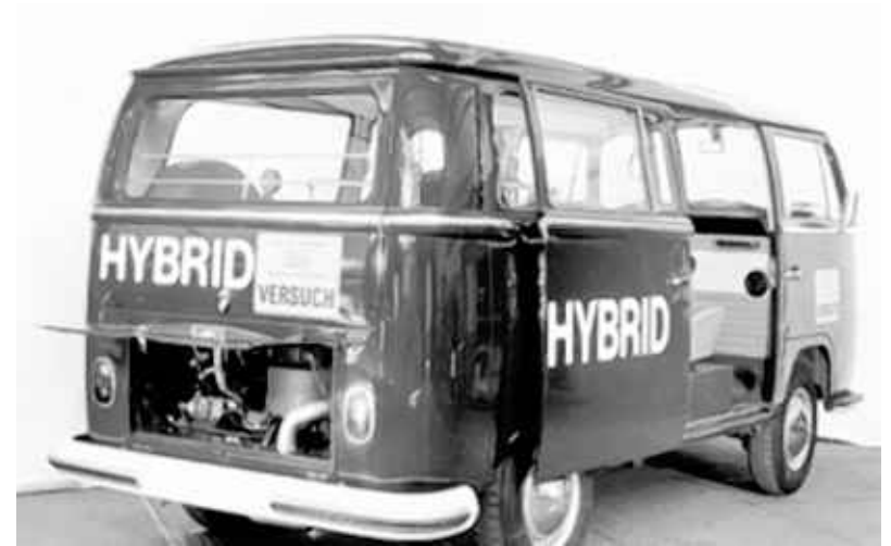
Mit der Kraft der zwei Herzen: Schon 1972 kombinierten Aachener Ingenieure einen Benzin- und einen Elektromotor in diesem VW-Bulli. Der Antrieb ist jetzt im Essener Haus der Technik, einem RWTH-Außeninstitut, ausgestellt. Foto: Jan-Welm Biermann
